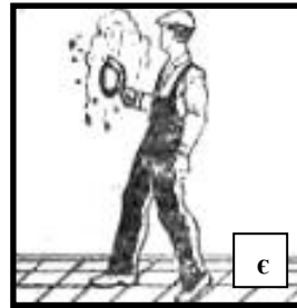
є – різким рухом ковша донизу виплеснути розчин на поверхню, затримавши ківш на рівні стегна (усі рухи виконуються безперервно)
